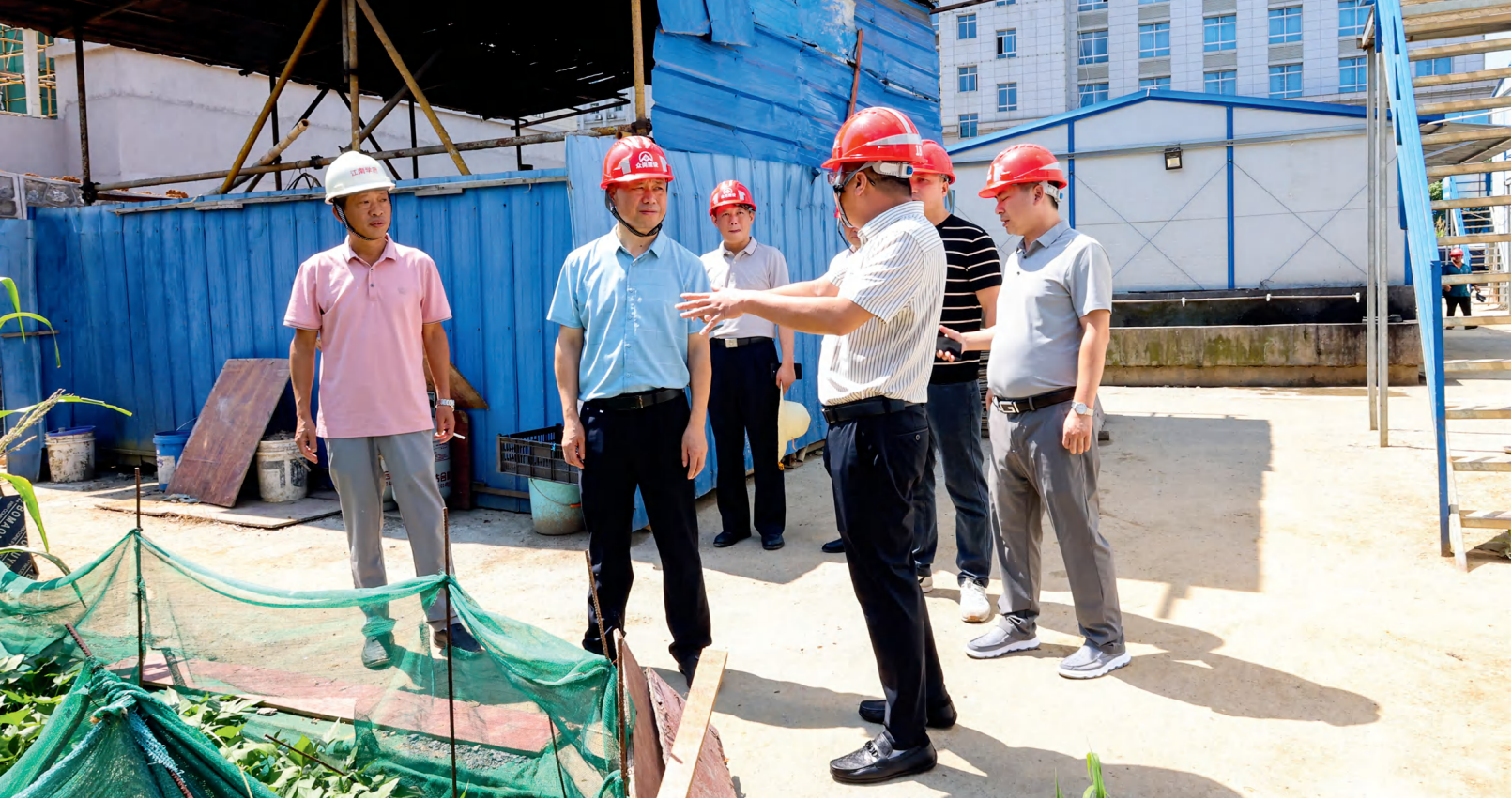
汝城县人大常委会执法检查组就安全生产“三法一条例两办法”实施情况开展现场检查。
