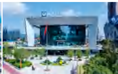
临湘市智慧政务中心。
