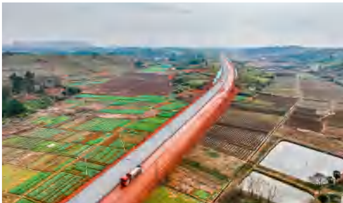
107国道耒阳绕城公路项目施工有序推进。
