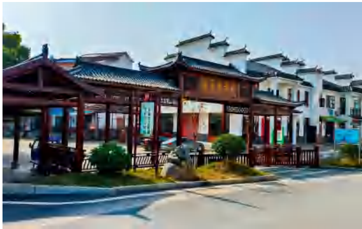
攸县丫江桥镇仙石村新农村规范建房示范点。
