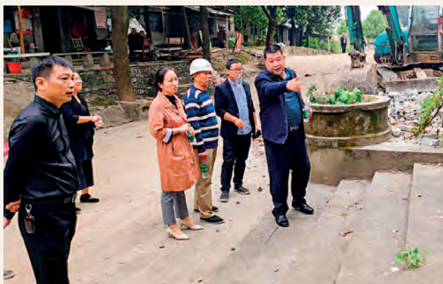
氮肥厂老旧小区改造。
