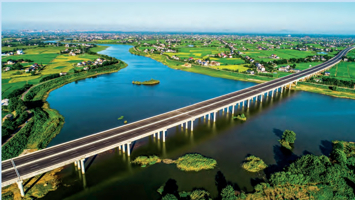
长益高速公路扩容工程通车，有效缓解湘西北交通出行压力。
