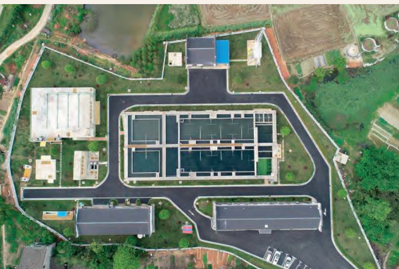
建成后的兰溪镇污水处理厂。
