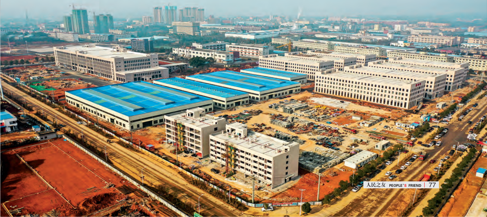
电子信息产业园项目施工现场。
