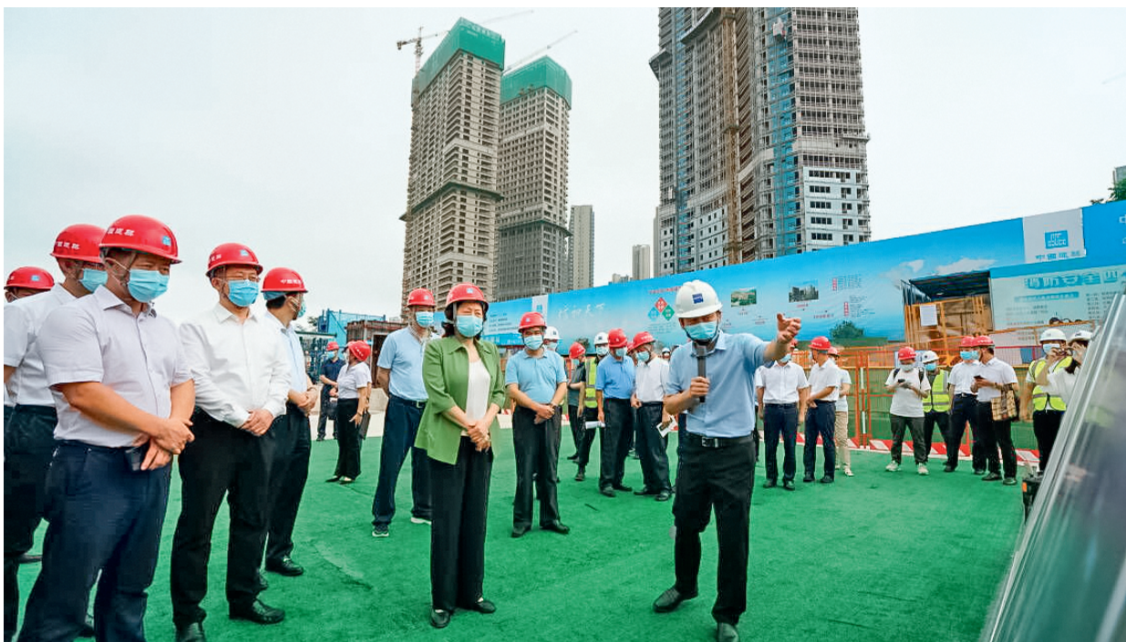
8月24日，省人大常委会党组书记、副主任刘莲玉率执法检查组在长沙市检查《中华人民共和国安全生产法》《湖南省安全生产条例》实施情况。图为刘莲玉一行在位于岳麓区的金茂梅溪大厦在建工地检查了解情况。摄影/周洁
