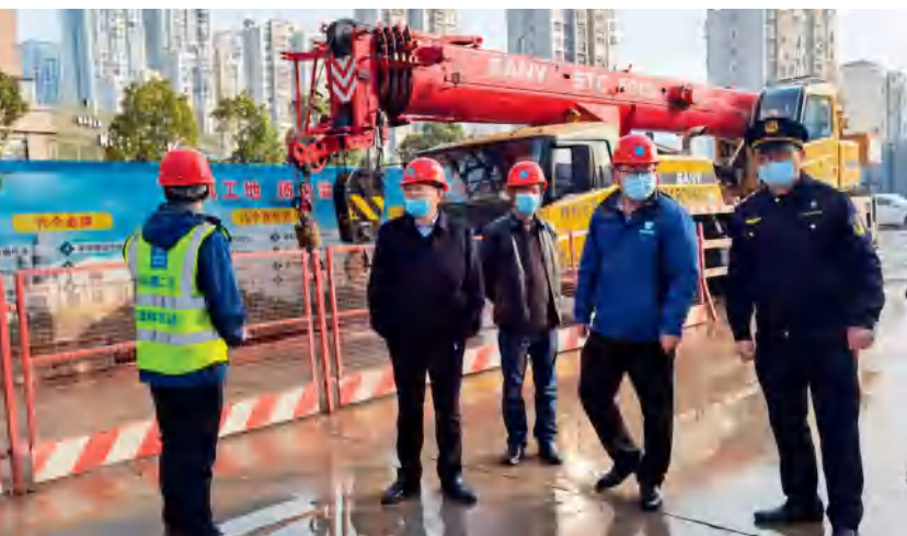
1月12日，长沙县人大常委会调研组现场调研建筑工地环保工作情况。
